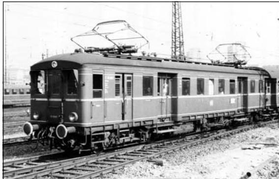
Im Jahr 1933 wurde mit der Elektrifizierung der Strecke Stuttgart - München auch der Vorortverkehr auf der Strecke Esslingen - Stuttgart - Ludwigsburg mit elektrischen Triebwagen aufgenommen. Dafür beschaffte die Deutsche Reichsbahn bei der Maschinenfabrik Esslingen die Triebwagen eT 1201 bis 1225, die spätere Baureihe ET 65. Die erste Serie umfasste 17 Triebwagen und 16 Steuerwagen.
