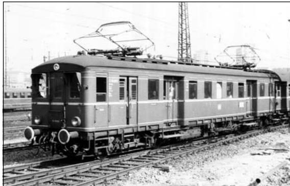
Im Jahr 1933 wurde mit der Elektrifizierung der Strecke Stuttgart – München auch der Vorortverkehr auf der Strecke Esslingen – Stuttgart – Ludwigsburg mit elektrischen Triebwagen aufgenommen. Dafür beschaffte die Deutsche Reichsbahn bei der Maschinenfabrik Esslingen die Triebwagen eIT 1201 bis 1225, die spätere Baureihe ET 65. Die erste Serie umfasste 17 Triebwagen und 16 Steuerwagen.
