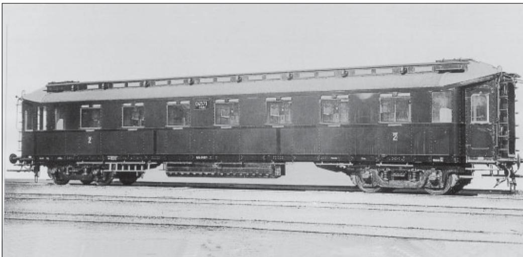
Ab 1912 beschaffte die preußische Staatsbahn die ersten D-Zugwagen in "eiserner Bauart". Die D-Zugwagen eiserne Bauart DRG waren durch Nieten an den Seitenwänden erkennbar.
